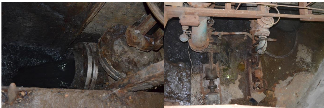
Figura 4-14: Stația de pompare principală a apelor uzate SPPAU
