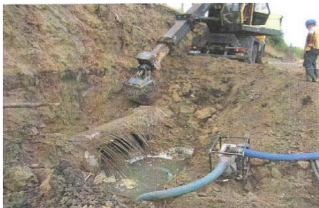
Fig. 6.9. Corodarea armăturii la tuburile PREMO a condus la explozia tubului
