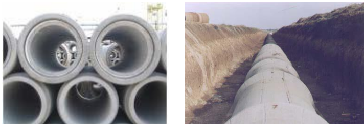
Fig. 5.7. Tuburi de beton cu îmbinarea caracteristică
