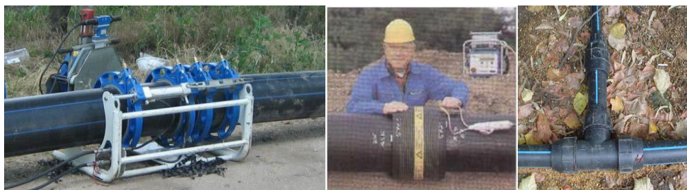
Fig. 5.4. Îmbinarea tuburilor prin sudare cap la cap, cu manșon electrosudabil și cu îmbinare demontabilă
