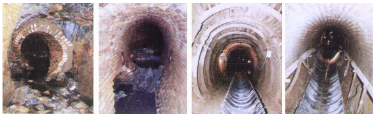
Fig. 5.9. Colectoare din zidărie cu și fără protecție anticorozivă
