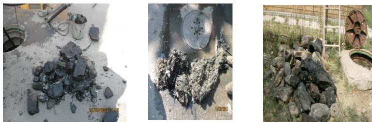
Fig. 6.13. Materiale ce blochează rețeaua de canalizare
