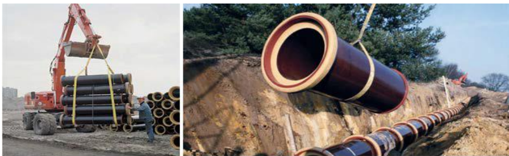
Fig. 5.13. Tuburi de gresie antiacidă
