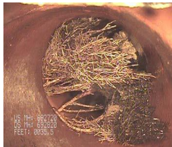
Fig. 6.11. Dezvoltarea de rădăcini în conducte și canale
