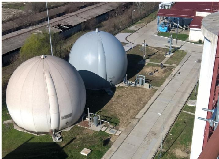
**Baloanele colectoare de biogaz cu o capacitate de 1500 mc fiecare**
