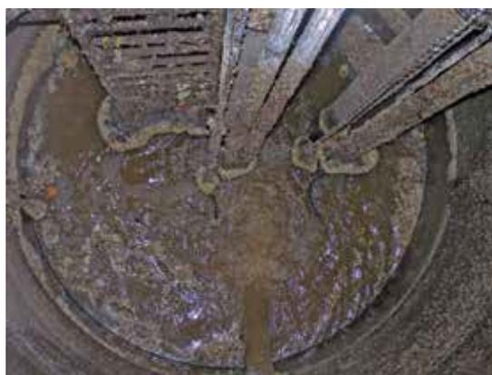
Figura 5. Mari cantitati de solide conduc la dese colmatari
