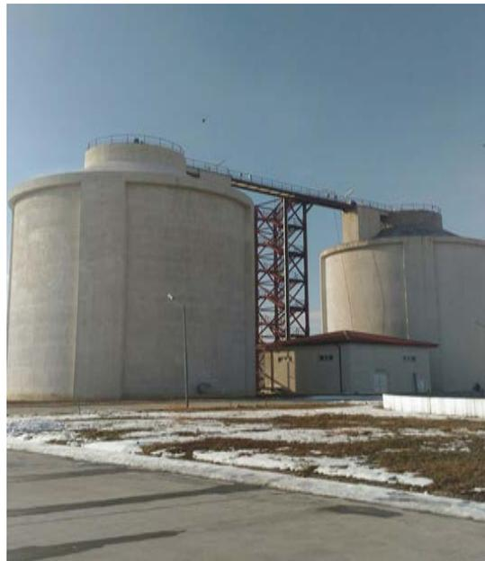
**Fermentatoarele anaerobe, capacitate 6000 mc fiecare**
